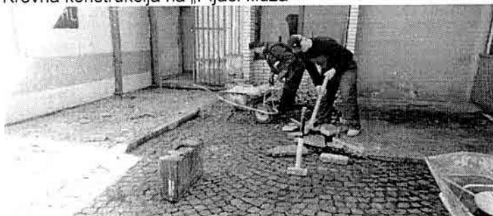
Početak radova na izgradnji poslovnog prostora na „Pijaci Vogošća”
