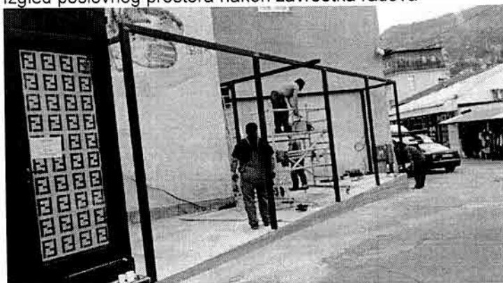
Uposlenici Službe za razvoj i održavanje prilikom izvođenja radova
